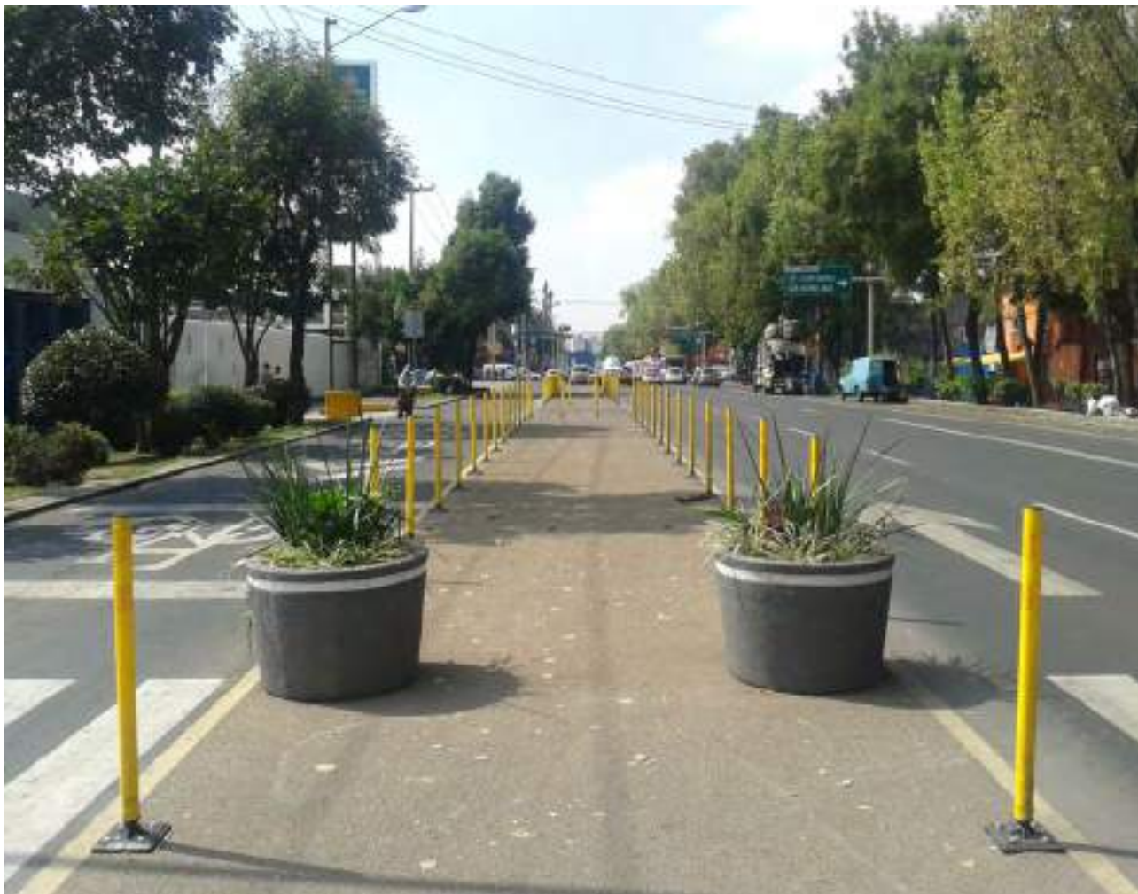
Corredor Eje 1 Oriente La Viga
