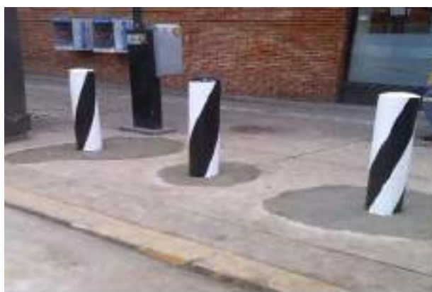
Colocación de bolardos metálicos
