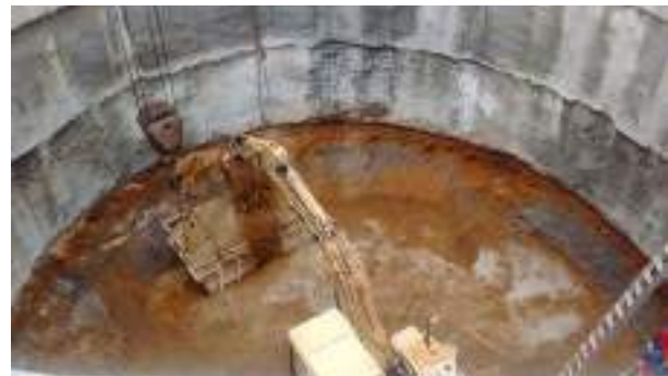
Extracción de material producto de demolición
