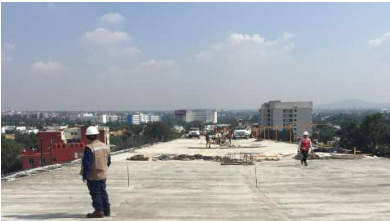
El uso de prefabricados en la Autopista Urbana Sur acorta los tiempos de obra
