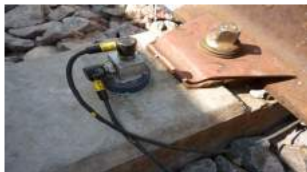
Sustitución de elementos de fijación
