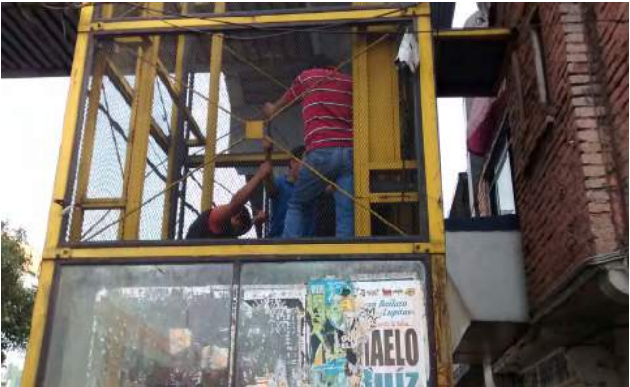
Reparación de elevador
