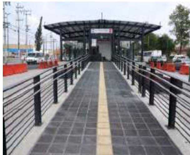
Guía táctil, barandal de protección y de apoyo en las estaciones
