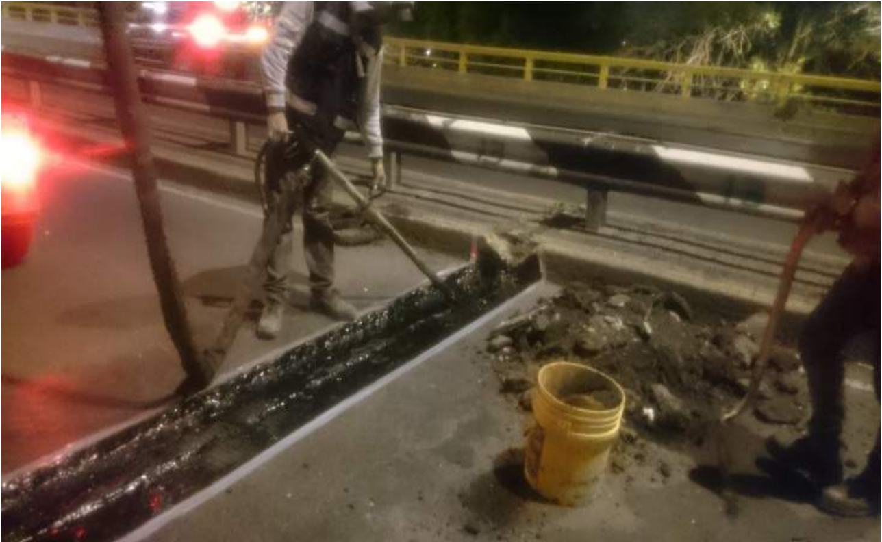
Distribuidor vial en Calzada México Tacuba - Avenida Marina Nacional
