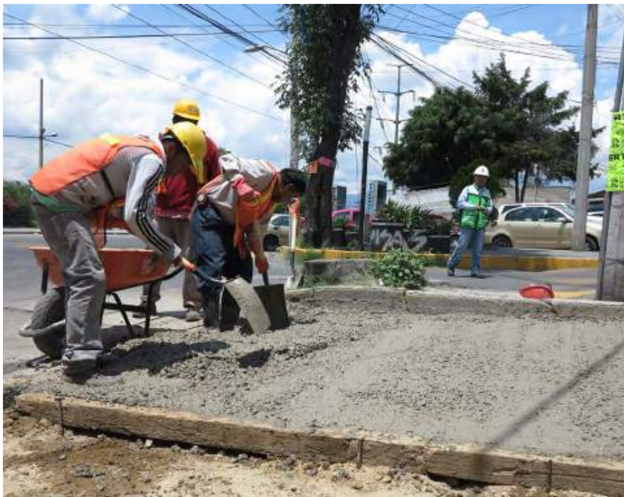
Tendido de concreto para construcción de banqueta
