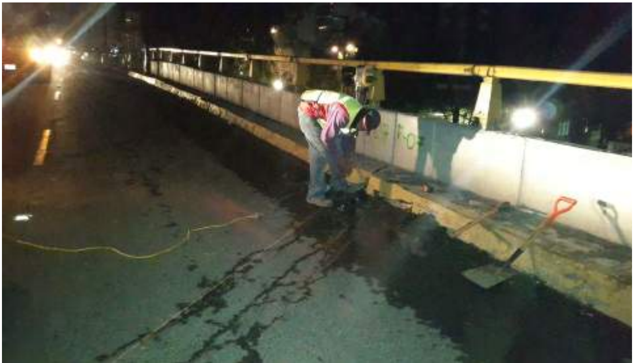
Puente en Avenida Fortuna y Eje Centraln
