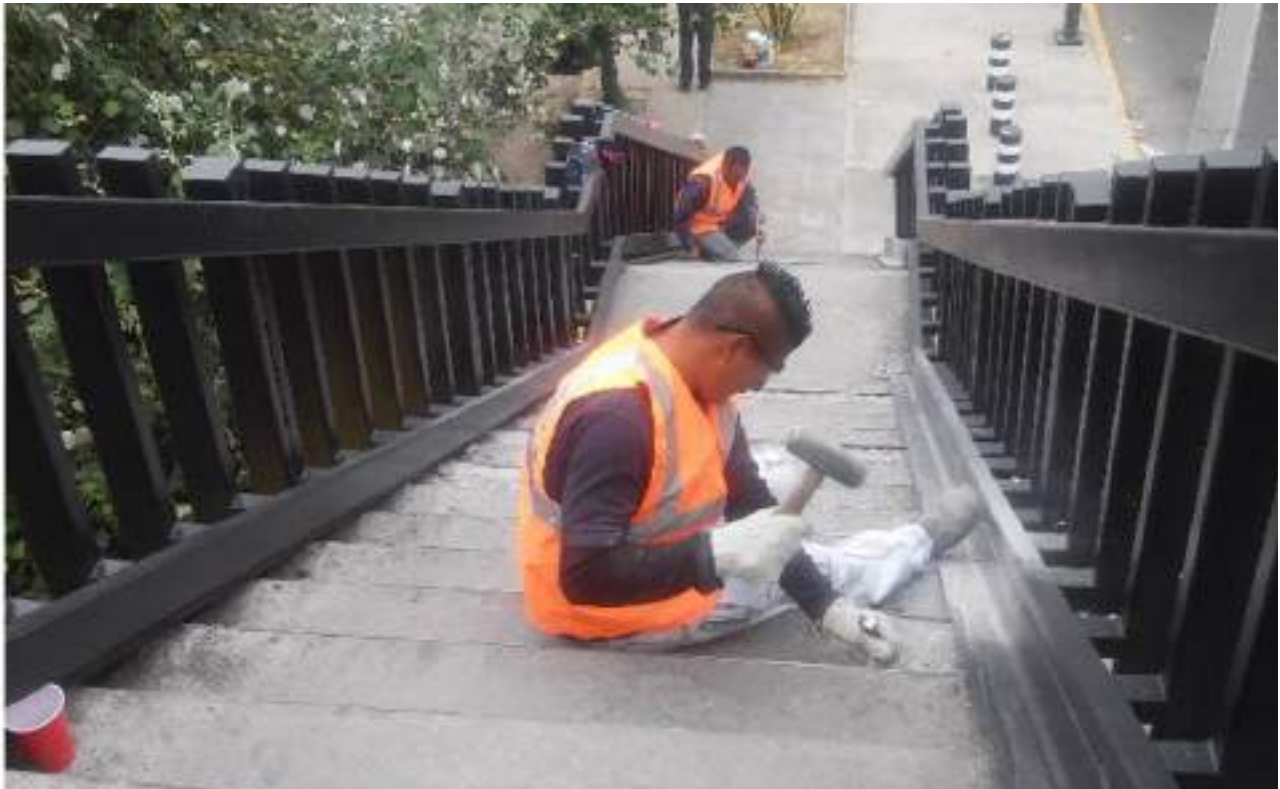
Reparación de escalones
