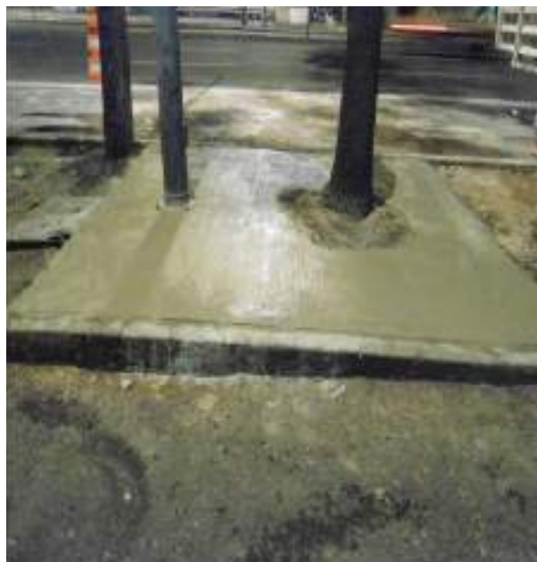
Colado de banqueta
