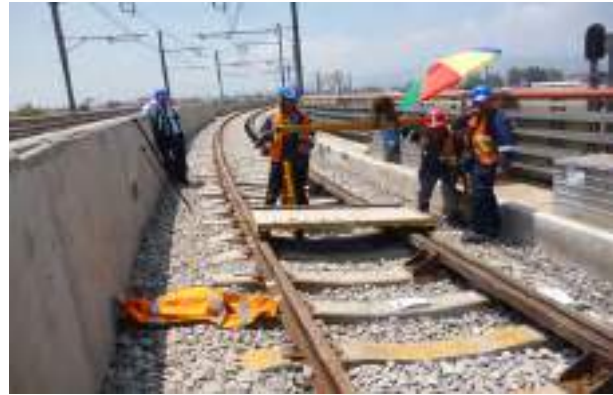
Reposición de durmientes
