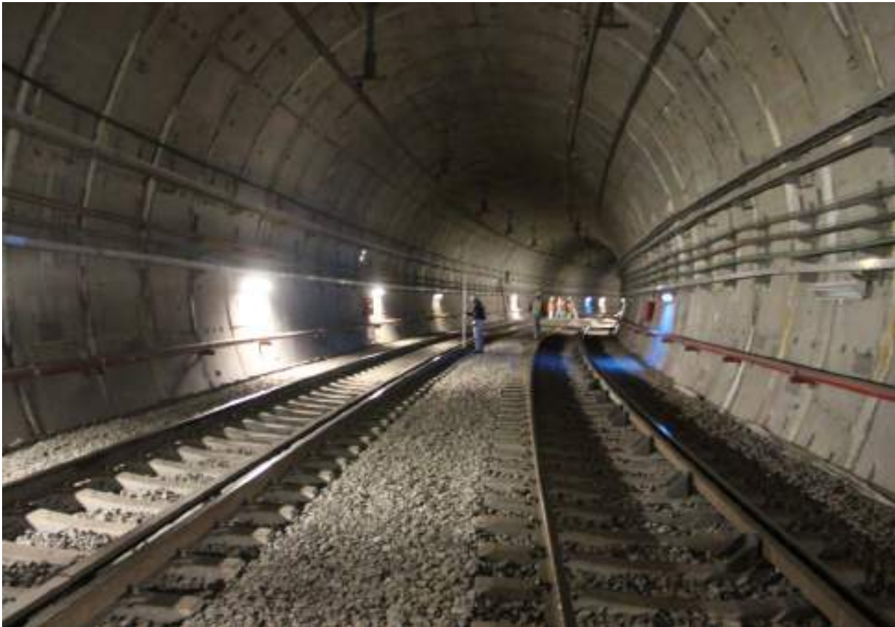
Levantamiento topográfico en túnel, para verificación de niveles en vías con estación total
