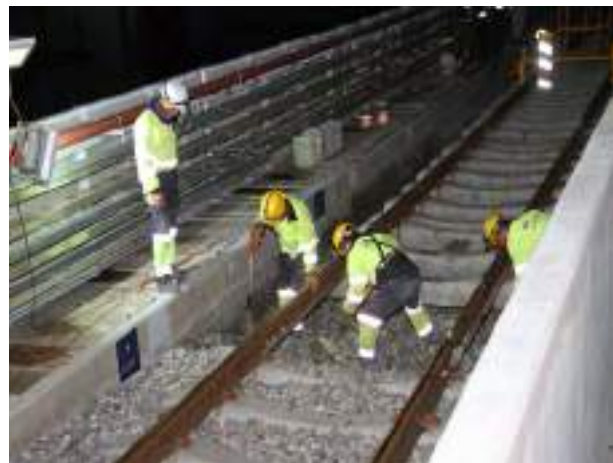
Sustitución de balasto
