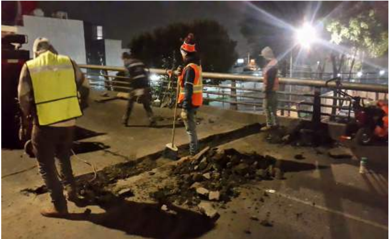
Puente en Eje 3 Oriente y Eje 3 Sur
