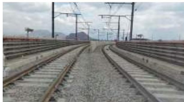
Nivelación general de vía
