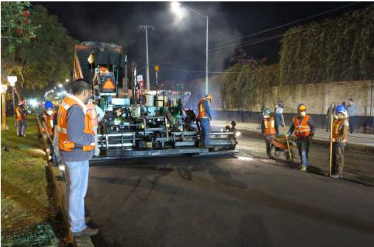
Preparación del tren pavimentador para trabajo nocturno
