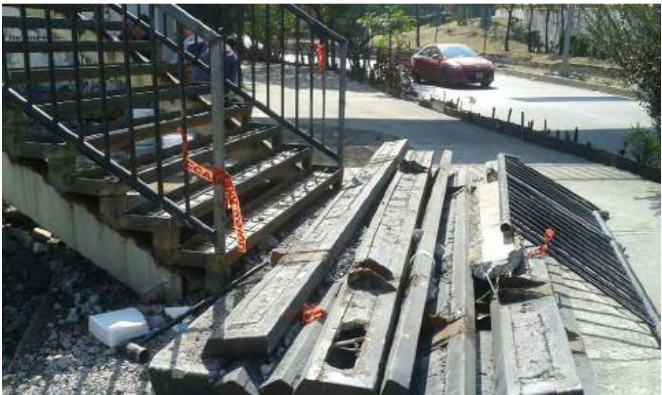
Sustitución de escalones
