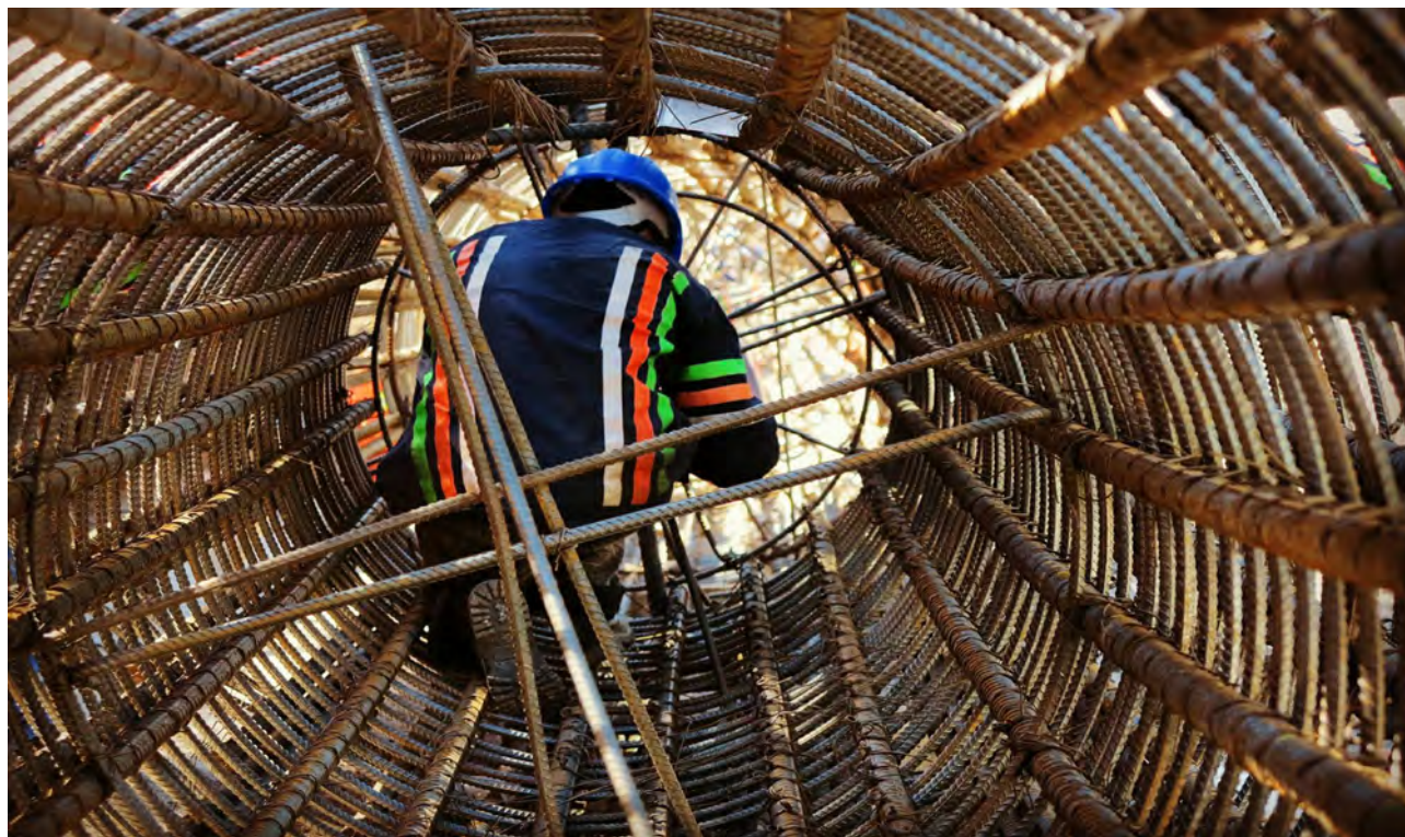
Armado de columnas coladas en sitio
