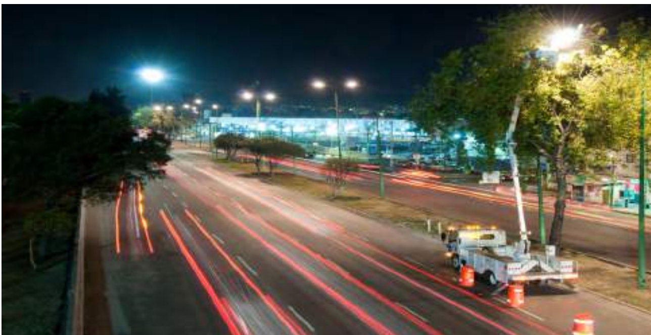
Sustitución de luminarios en vialidad primaria
