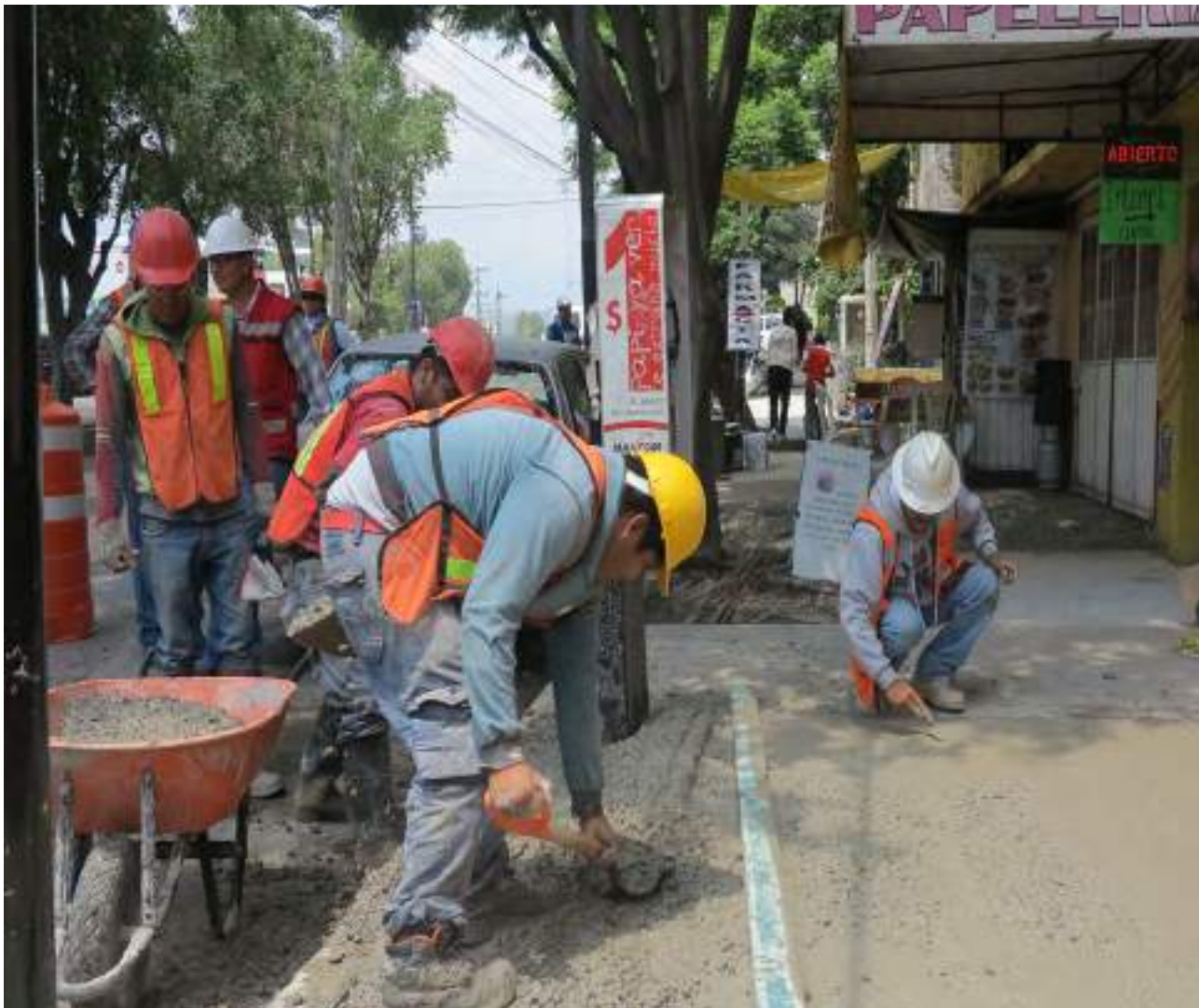
Colado en desnivel de banqueta en razo
