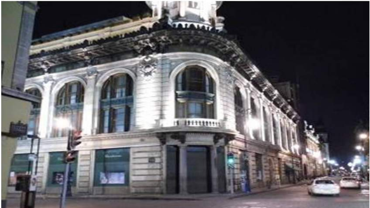
Iluminación de fachadas en edificios históricos
