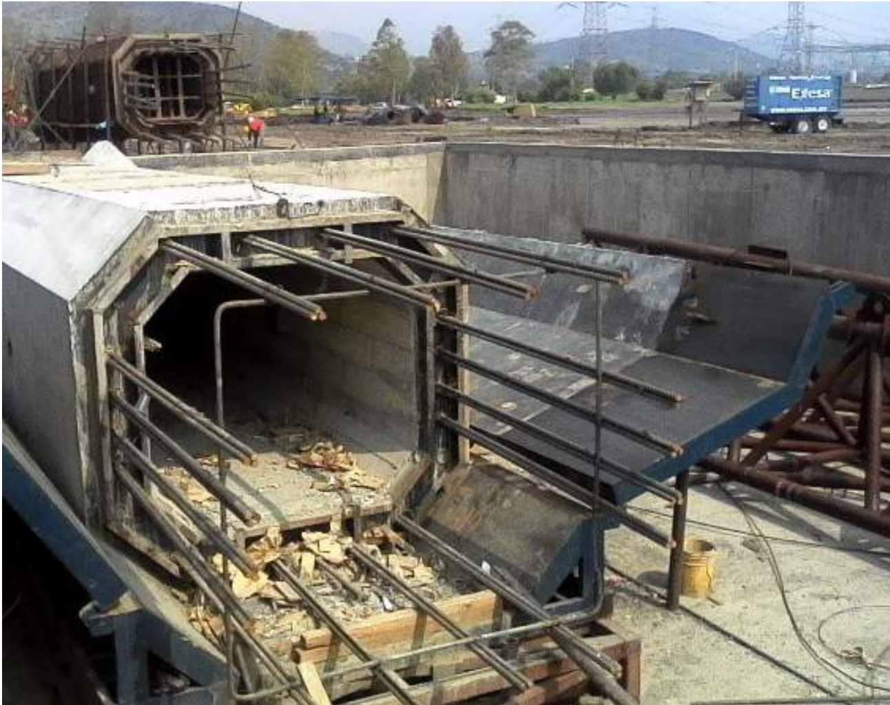
Fabricación de capiteles o remates de columnas para recibir traveses
