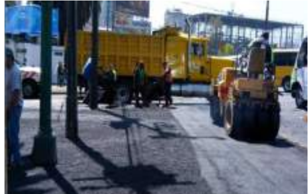
Compactación de tendido de la mezcla asfáltica
