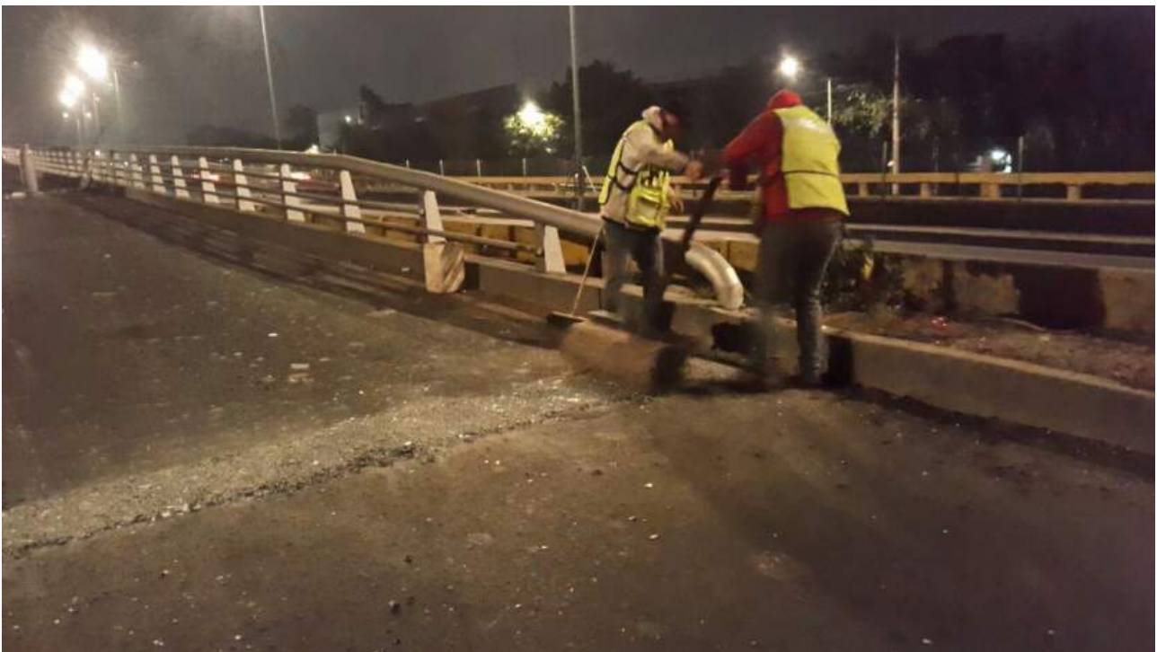
Distribuidor vial Periférico Canal de Garay
