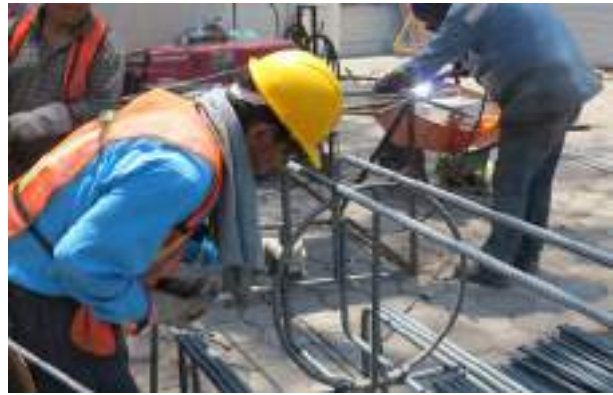
Armado y colado de pilas de contención para el desvío del Colector Río Becerra
