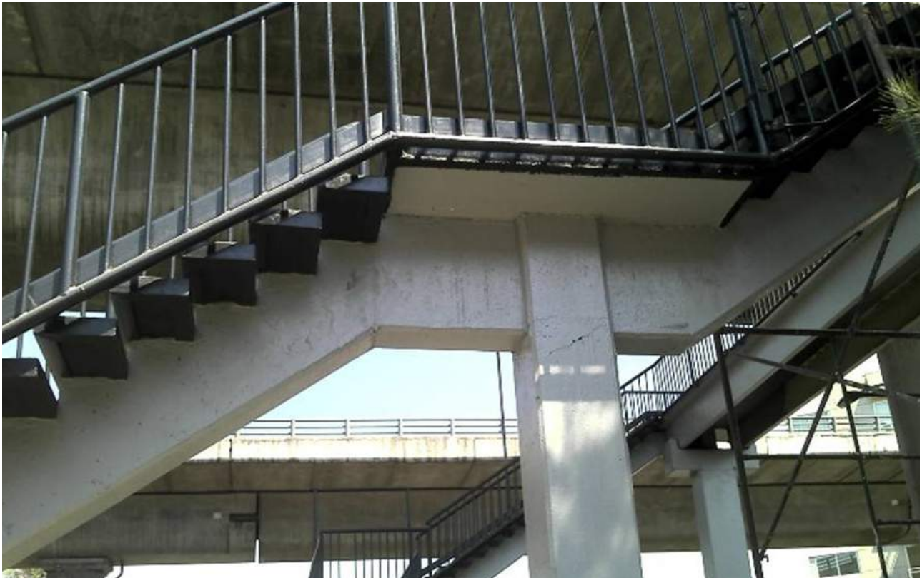
Distribuidor vial en Calzada México Tacuba - Avenida Marina Nacional
