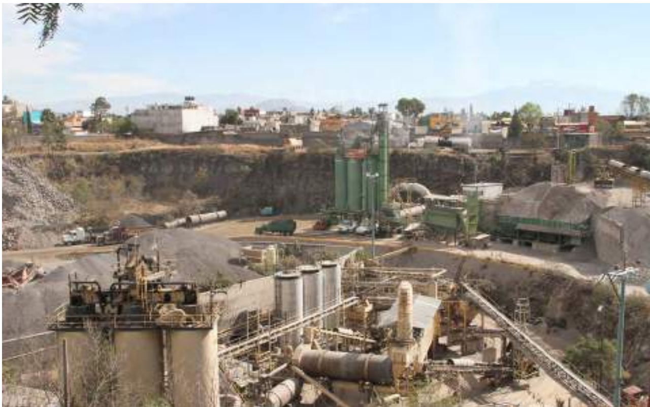
La mejora de esta edificación será integral pues además de adecuar los procesos de fabricación de asfalto , los habitantes aledaños podrán disfrutar de la remodelación de esta zona
