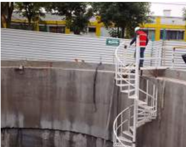
Brocal terminado (primer anillo perimetral)
