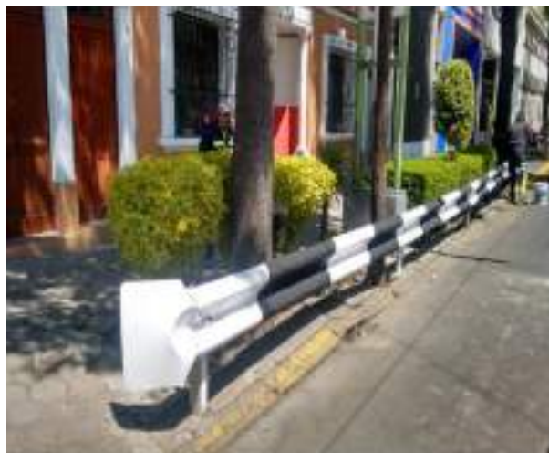
Aplicación de pintura en defensa metálica
