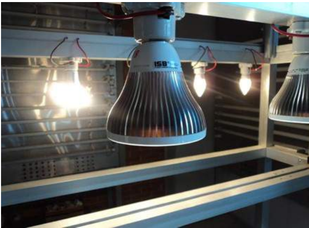
Pruebas de niveles de iluminación
