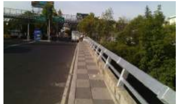
Aplicación de pintura en parapeto metálico
