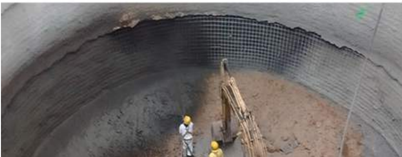
Armado de muro perimetral de los cinturones subsecuentes
