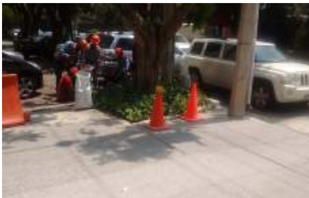
Evaluación a instalaciones subterráneas
