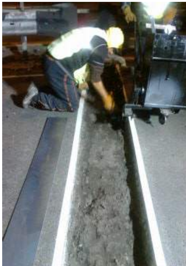
Corte de asfalto para retiro de junta
