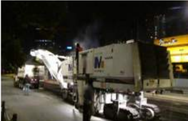
Operación del equipo de fresado
