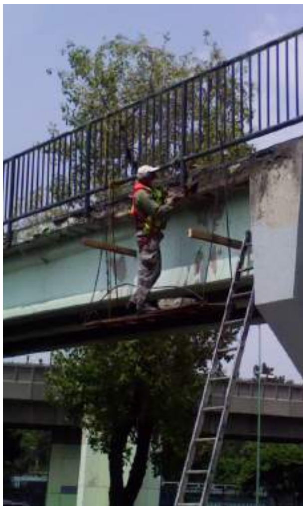
Escarificación de concreto
