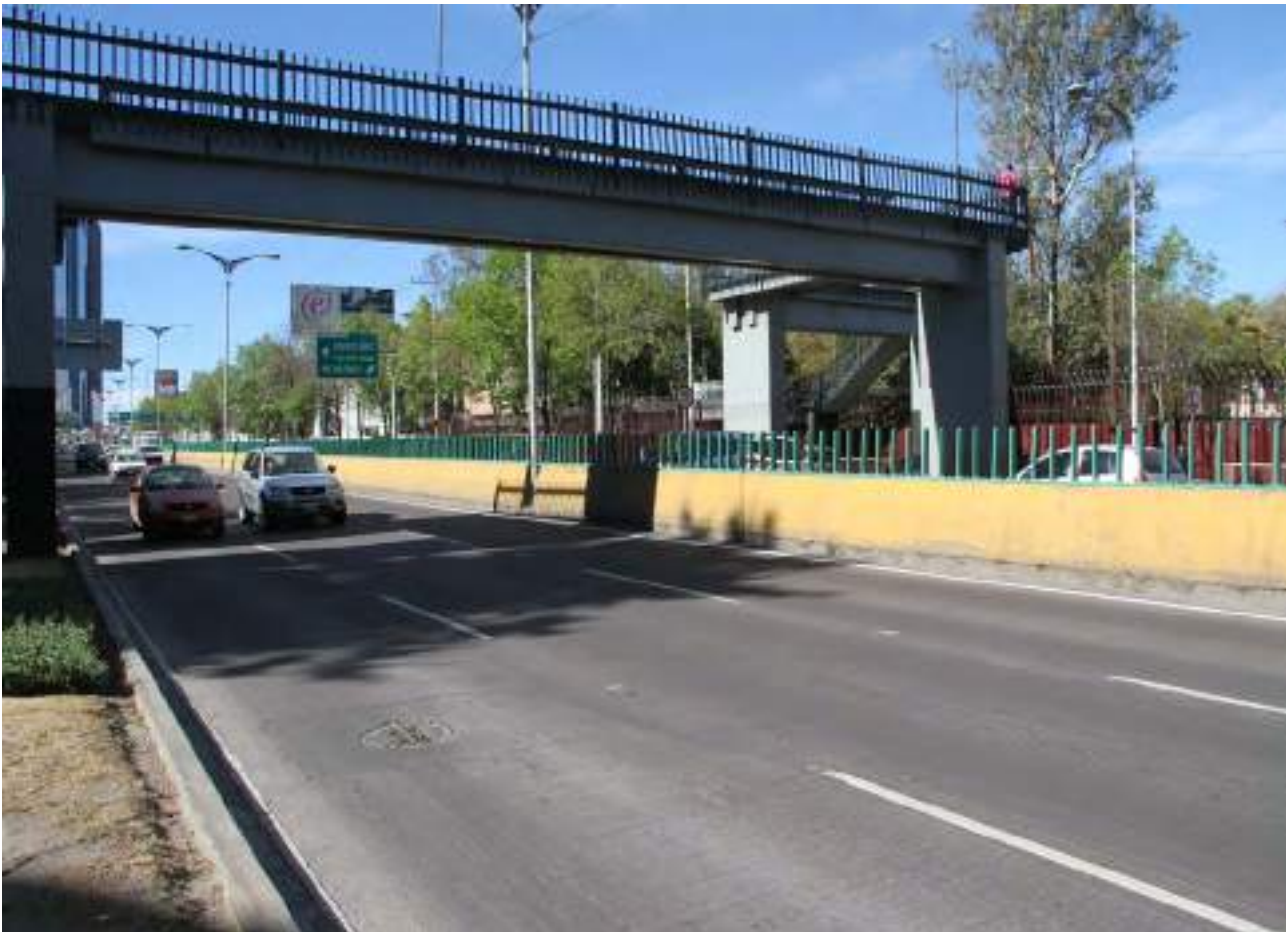
Trabajos de aplicación de pintura
