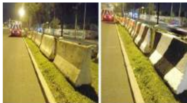
Aplicación de pintura en muro deflector de concreto
