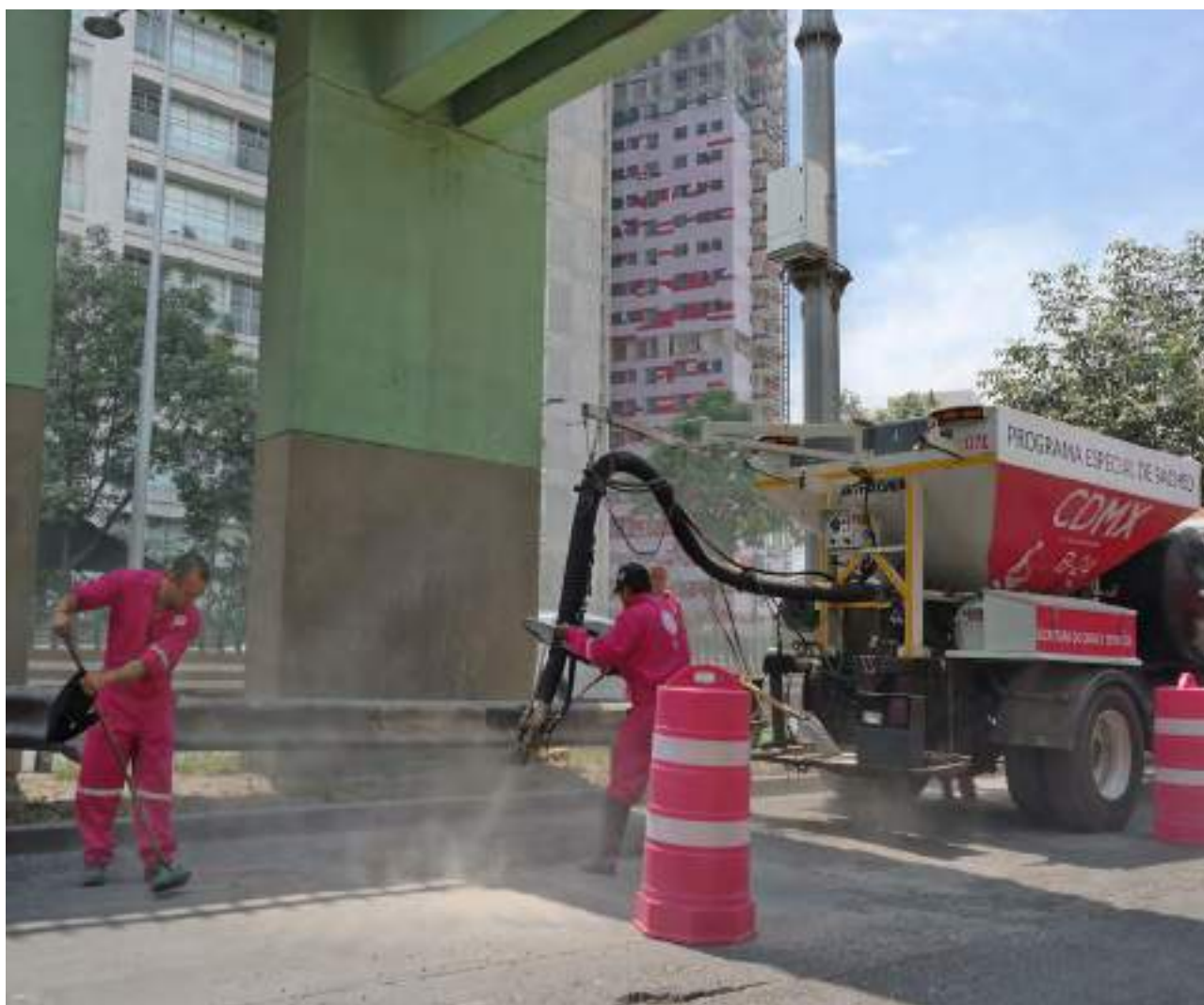
Tendido de material asfáltico (Brigadas Bache 24 )
