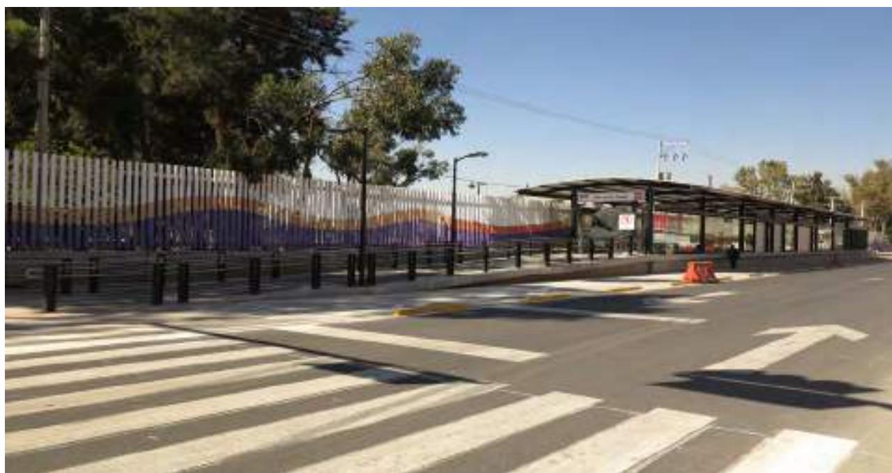
Señalamiento horizontal: balizamiento en carriles y cruces
