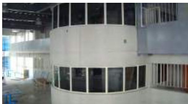
Área de control de custodios del CEVASEP II
